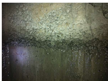
Požeminis vanduo prasiskverbia pro darbinę siūlę tarp senojo ir naujojo betono sluoksnio
