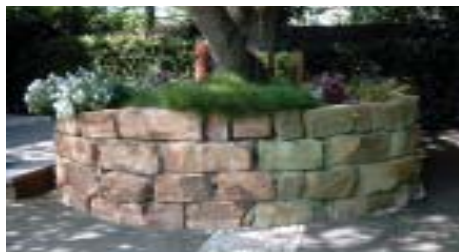
Клумба из природного камня: справа зазелененная, слева очищенная Лотугленом А и пропитанная Лотупором
